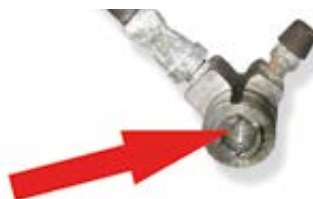
Foto 3: Kontrola złącza na przewodzie
